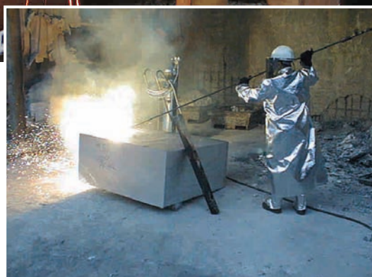
Betong skjæring
